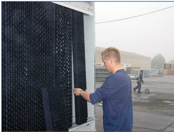
Kombinierte Lufteintrittsschutzelemente entfernen
