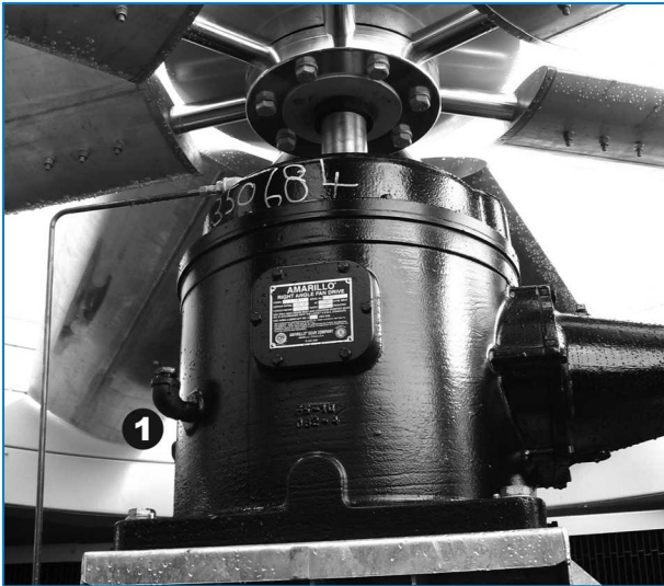
Getriebe mit einfacher Übersetzung
