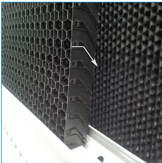
Ausrichtung des Lufteintrittsschutzelements
