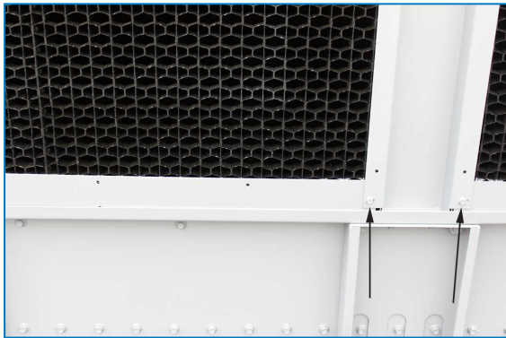
Transportbänder entfernen
