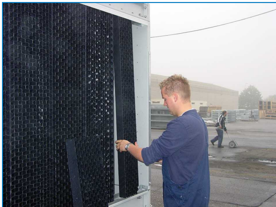
Kombinierte Lufteintrittsschutzelemente entfernen
