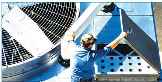
Heißwasserbecken und optionale Abdeckungen Wasserverteilwanne
