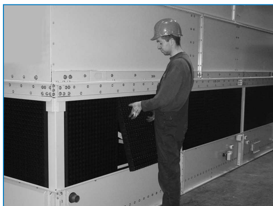
Kombinierte Lufteintrittsschutzelemente entfernen
