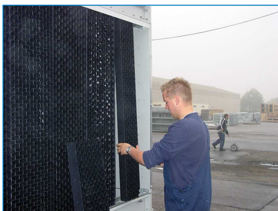
Rimuovere gli schermi d'ingresso combinati
