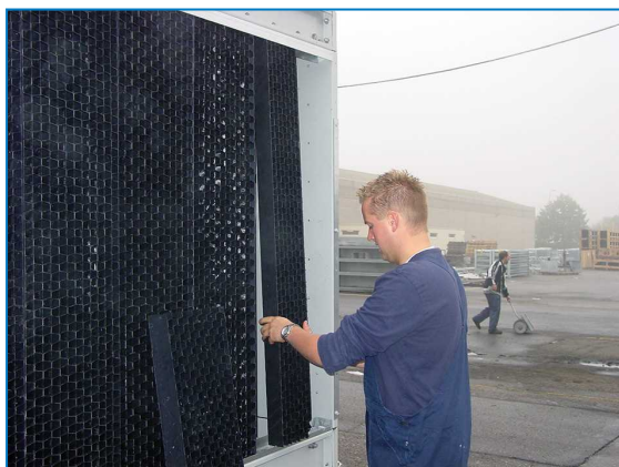
Rimuovere gli schermi d'ingresso combinati
