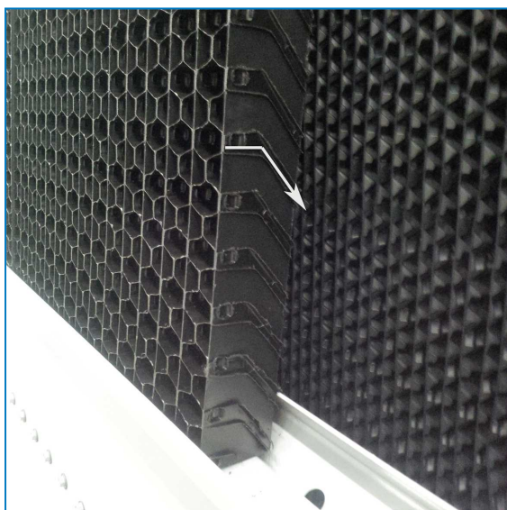
Orientamento dello schermo d'ingresso combinato
