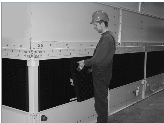
Rimuovere gli schermi d'ingresso combinati.
