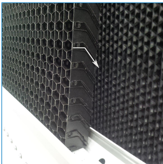
Orientamento dello schermo d'ingresso combinato
