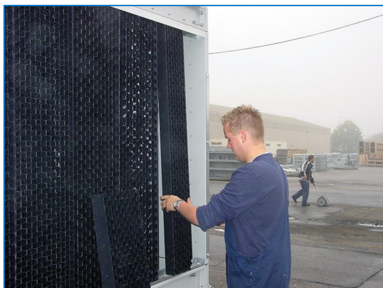
Rimuovere gli schermi d'ingresso combinati.
