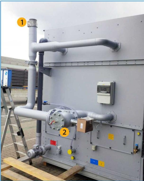
Appareil avec tuyauterie extérieure fermée
