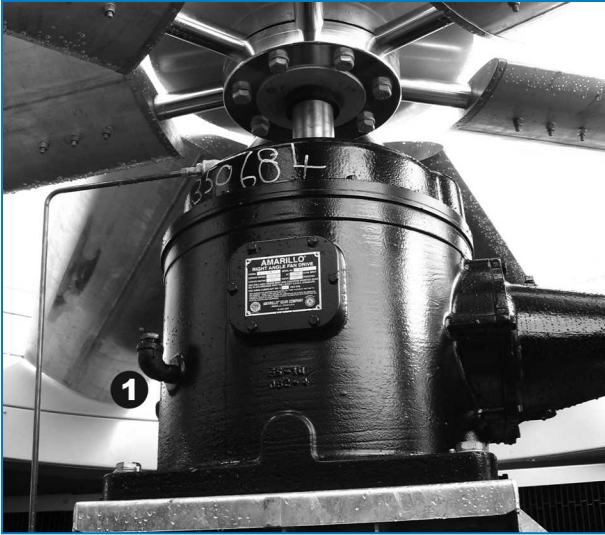
Transmisión por caja reductora con reducción simple
