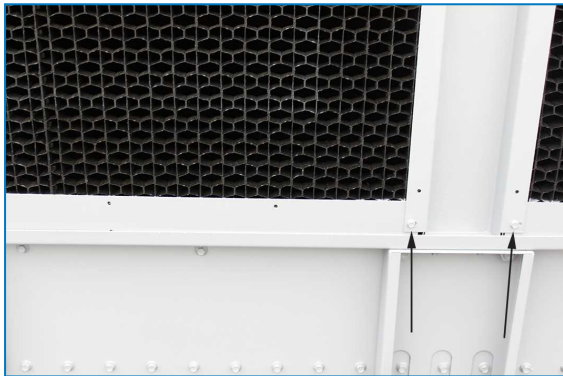
Retirada de las correas de envío
