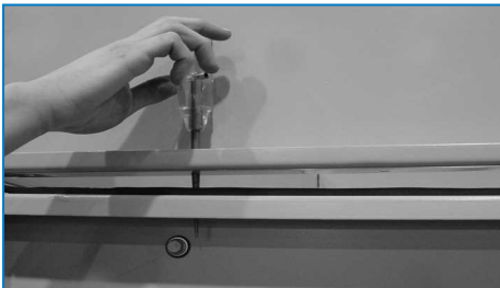
Uso de pasadores para alinear los agujeros atornillados
