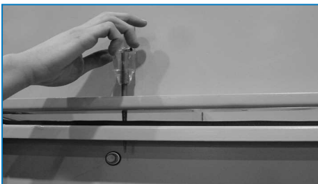
Verwendung des Treibdorns zur Ausrichtung der Schraublöcher
