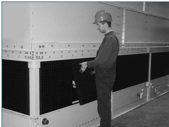
Снятие комбинированных щитов на входе
