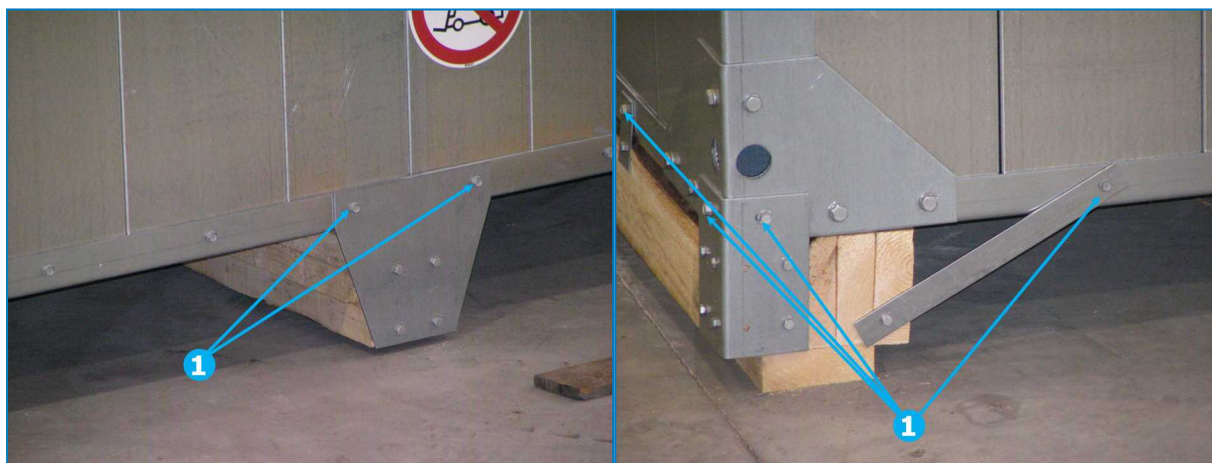
Демонтаж транспортировочных салазок — вид сбоку и вид с торца
