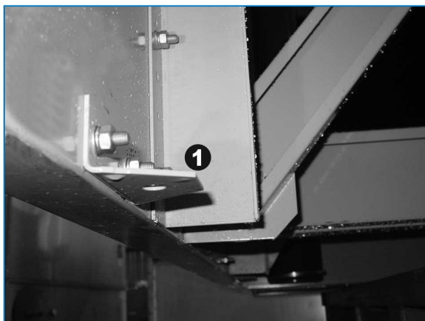
Вид секции вентиляционной камеры изнутри
