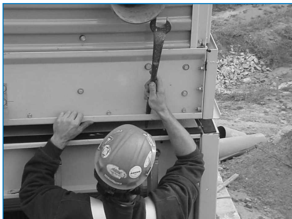
Соединение углов с помощью штифтов
