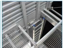
Plataformas internas de servicio*
