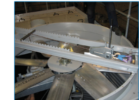
Extracción del equipo mecánico*
