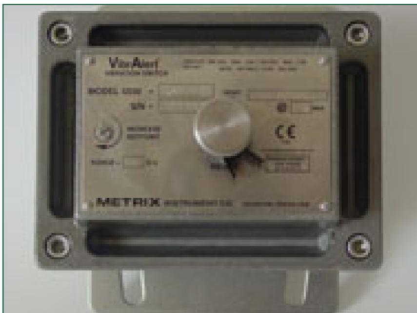
L'interrupteur **détecte toute vibration excessive du moteur du ventilateur** qui serait causée par le gel ou une quelconque défaillance mécanique. Bien que monté en usine, l'interrupteur est ajusté sur place au cours de l'installation et de la mise en service.
