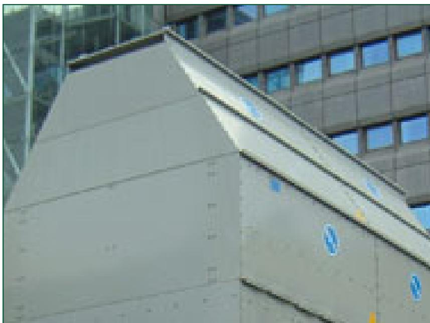
Los plenums de descarga le permiten cumplir con las restricciones de diseño **elevando la** descarga de la unidad por encima de las paredes adyacentes e incrementando la velocidad del aire impulsado para **reducir el riesgo de recirculación** en espacios confinados.
