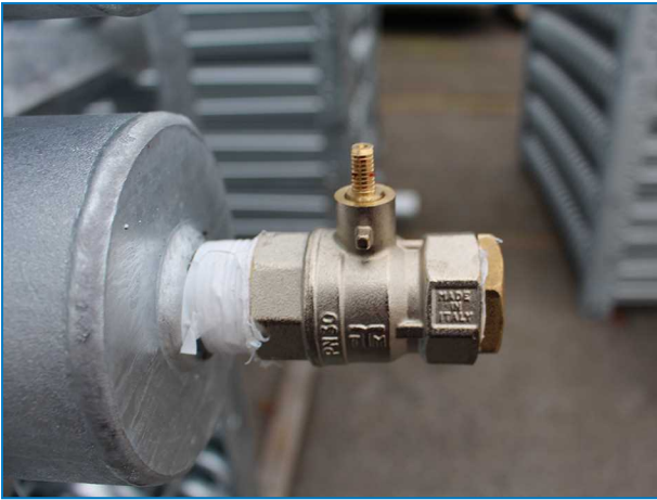
Bovenste batterijaansluiting met drukaflaatklep op koeltorens met gesloten kringloop met aansluitingen groter dan ND100.
