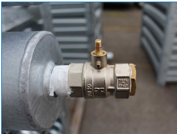
Övre slingkoppling med övertrycksventil på kondensorer.
