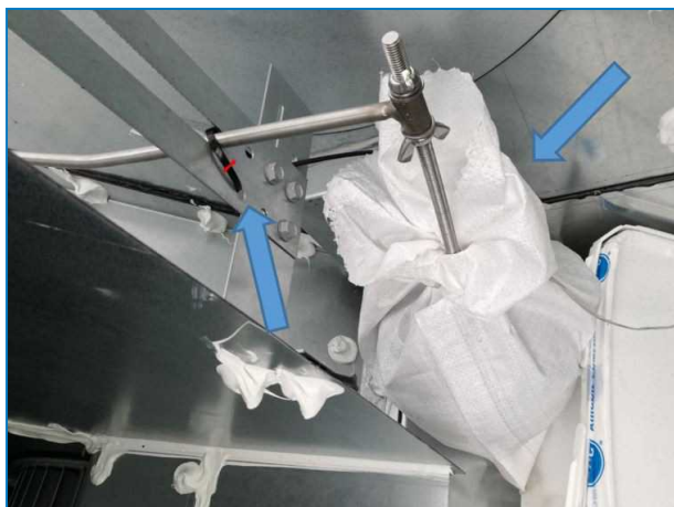
Montaż i owijanie kuli pływaka
