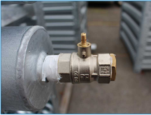
Conexión de batería no roscada con válvula de alivio de presión en equipo de almacenamiento térmico para alimentación de refrigerante directa.
